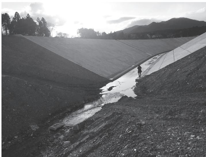
写真2 気仙沼市の沖の田川に建設中の河川堤防。9m
