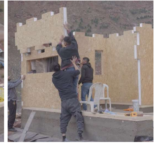
パネルの組み立て2
