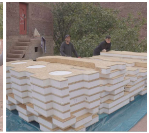
荷卸したパネル
