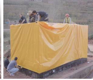
防水膜の施工
