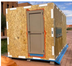
外壁解体後の様子
