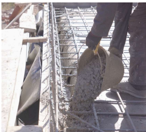
コンクリート打設
