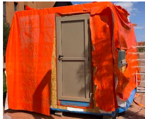
防水膜の取り外し
