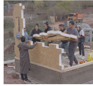
パネルの組み立て1
