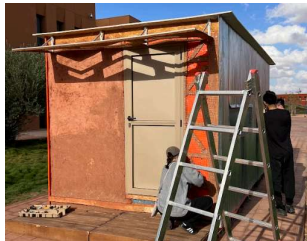
土壁の取り壊し
