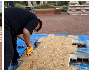
パネルの下部を切断
