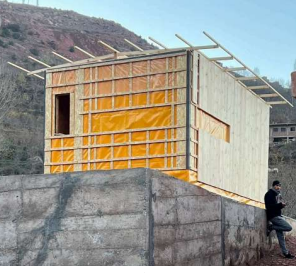
ファサードの施工
