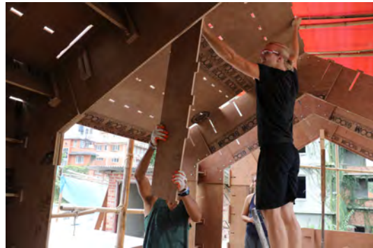
組み立て中の様子
