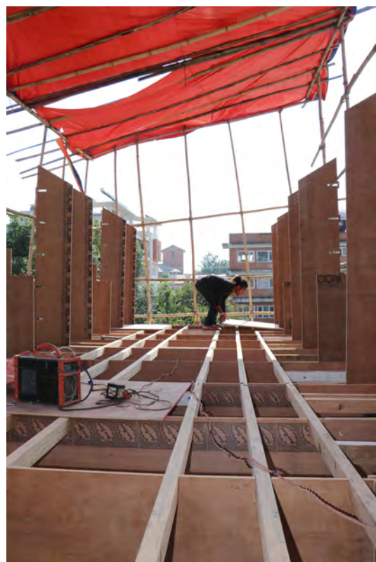
組み立て中の様子 2
