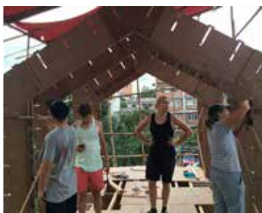
[9月] 現地のボランティア団体との施工の様子。
