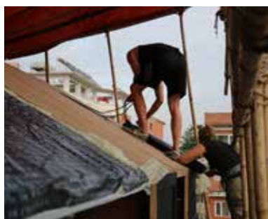
[10月] 外装工事の様子。
