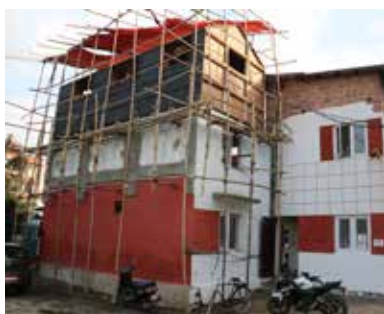
工事の様子 (10月6日撮影)
