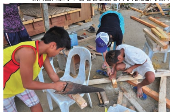
地元住民と協同で施工を行う
